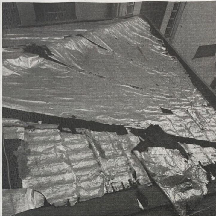
Figura 6: Telha coberta com manta impermeabilizante
