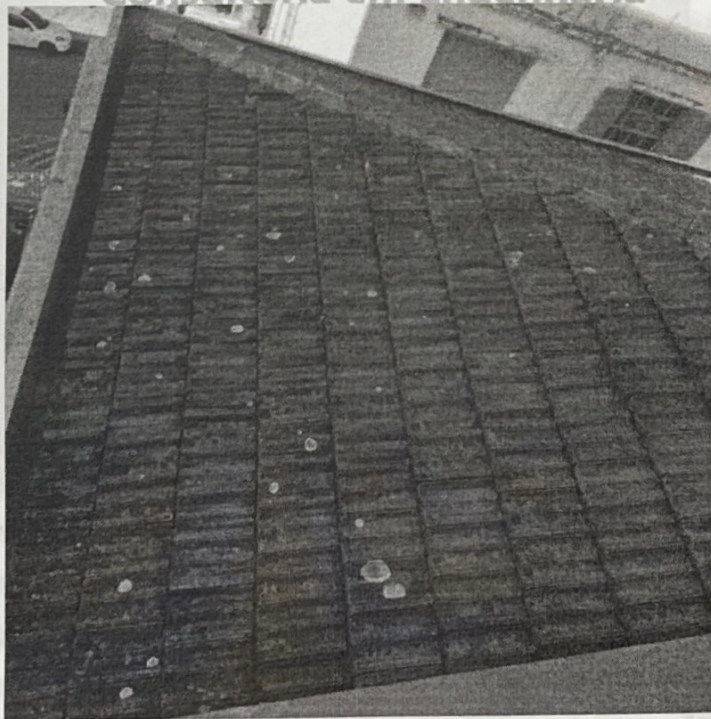
Figura 7: Telha coberta francesa aparente (fundos do telhado)
