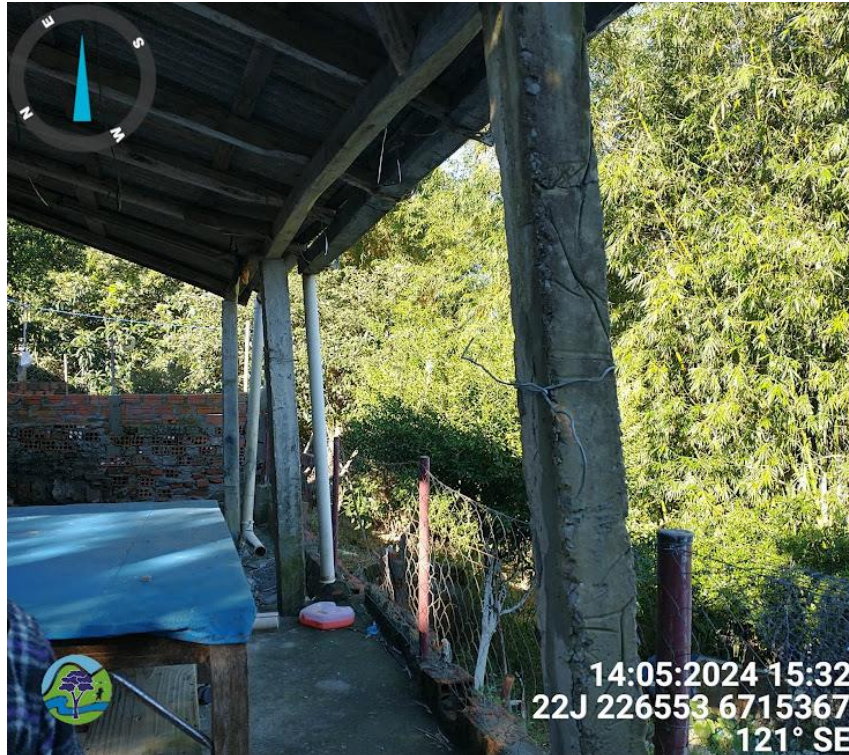
Figura 6 - Pilares inclinados.
